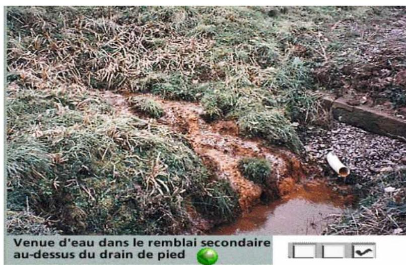
Fig. 7 : Symptôme visuel sur un barrage en remblai
