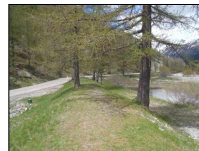
Digue de fermeture du barrage de CASTERINO (06) _ 2013
