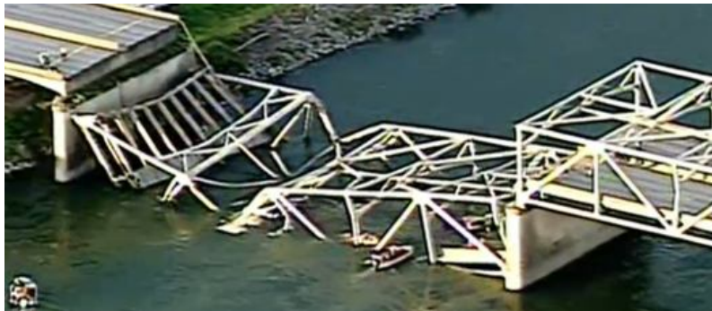
Figure 1. Effondrement du pont de Skagit sur la I-5.
